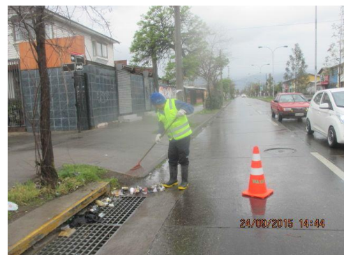
Limpieza de sumidero cuello Lo Ovalle
